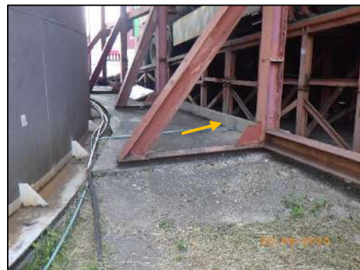
รูปที่ 2-27 คันคอนกรีตล้อมรอบถังเก็บกากน้ำตาล
