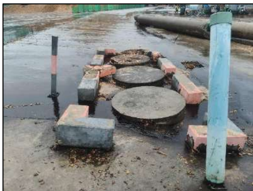
รูปที่ 2-32 บ่อรวบรวมน้ำชะกองไม้สับ
